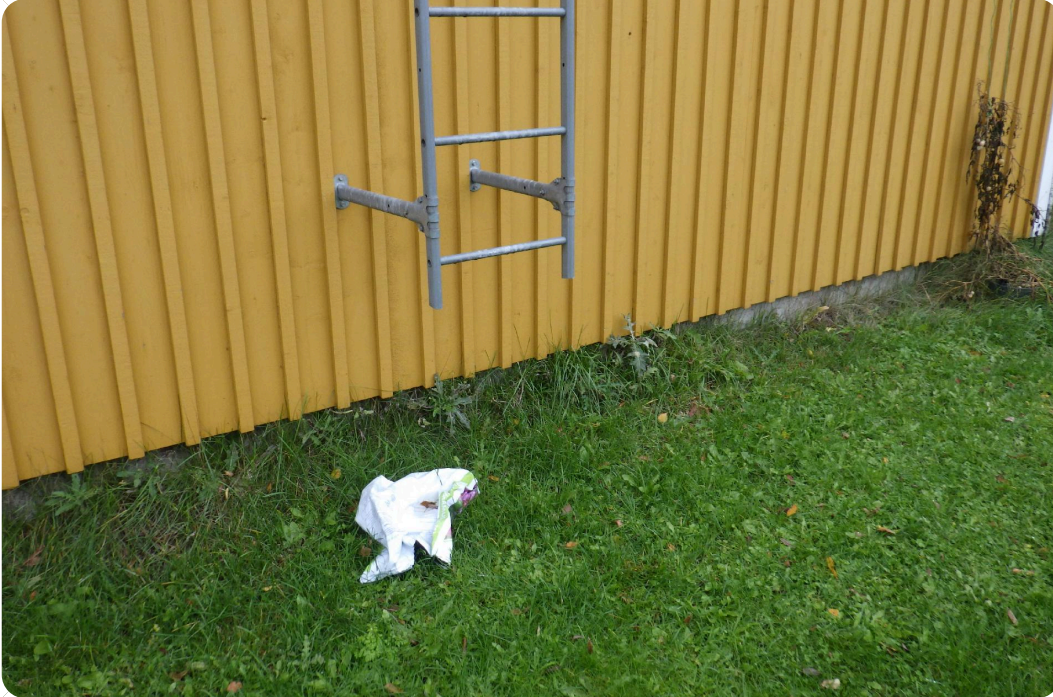
Havainto1 Talotikkaiden alin puola on liian matalalla lähtötasosta.
