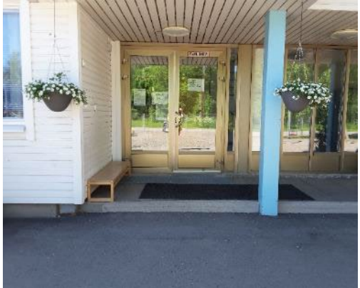
Luiska puuttuu (yllä) Kukeron puolella kaikkien ovien ja vaunujen säilytyspaikan edestä.
