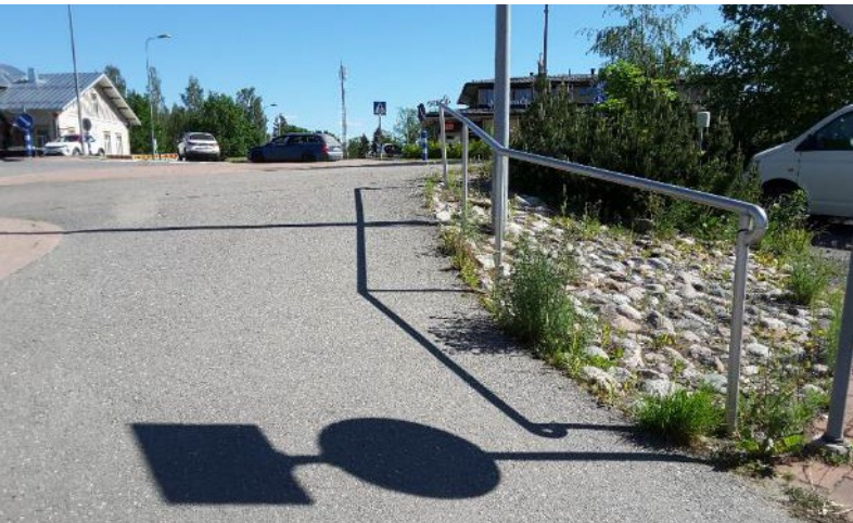
Mm. apteekille menevällä jkpp-väylällä Koskentie varrella pituuskaltevuus on jopa 15,7 %, joten uusi kaide helpottaa liikkumista.
