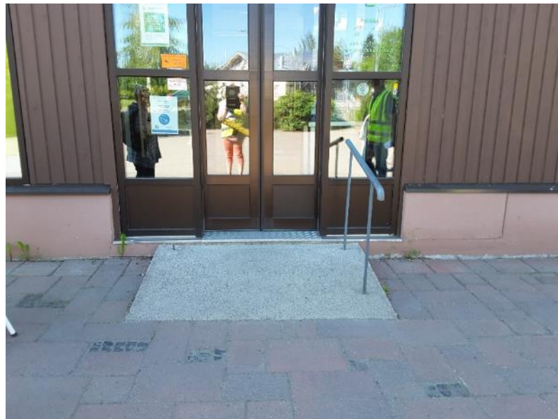
Mm. apteekille menevällä jkpp-väylällä Koskentie varrella pituuskaltevuus on jopa 15,7 %, joten uusi kaide helpottaa liikkumista.
