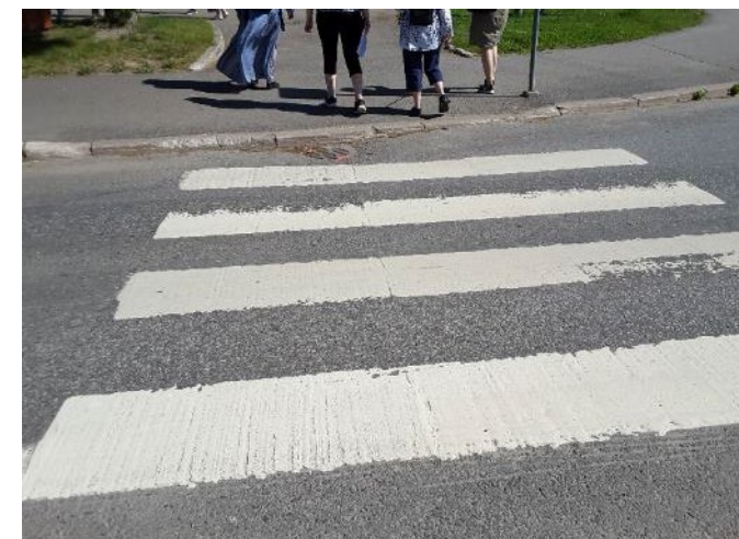
Reunatuet ovat liian korkeat Pieksämäentiellä Mutalantien liittymän läheisellä suojatiellä.
