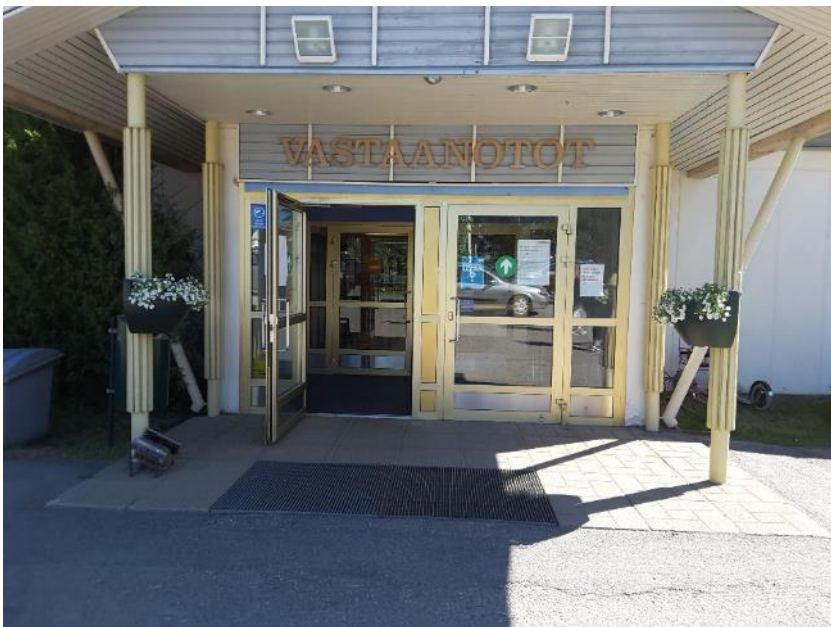
Terveyskeskuksen pääovi on esteettömyyden kannalta suhteellisen hyvä. Oven edestä voisi kuitenkin poistaa kynnyksen esim. luiskaamalla, jolloin pyörätuolilla kulku tilaa helpottuisi.
