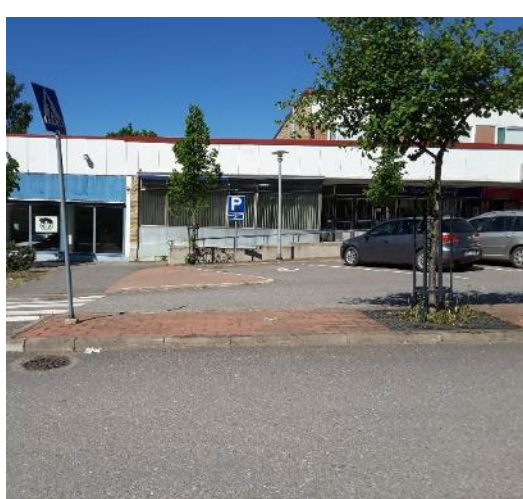
Koskentien varrella on LE-autopaikkoja, mutta maastonmuodoista johtuen sivukaltevuus niillä on liian suuri. LE-autopaikkojen reunassa on myös liian korkea reunatuki.
