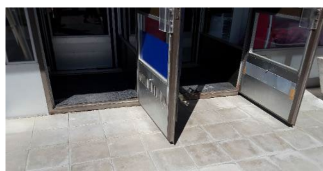
Liikkeiden oven edessä kynnykset ovat liian korkeat.
