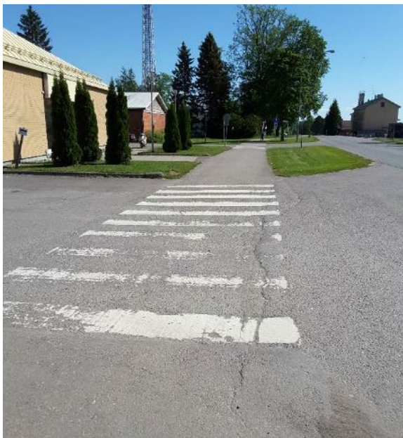
Työpajan liittymän suojatieltä puuttuvat reunatuet.
