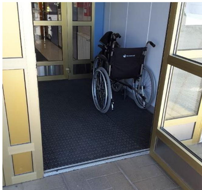
Terveyskeskuksen pääovi on esteettömyyden kannalta suhteellisen hyvä. Oven edestä voisi kuitenkin poistaa kynnyksen esim. luiskaamalla, jolloin pyörätuolilla kulku tilaa helpottuisi.
