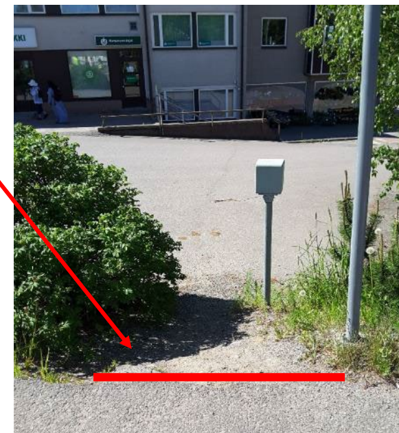
Jkpp-väylän ja parkkipaikan väliin olisi hyvä laittaa kaide, että esim. näkövammaiset ei vahingossa eksy reitiltä ja tipu parkkipaikalle.
