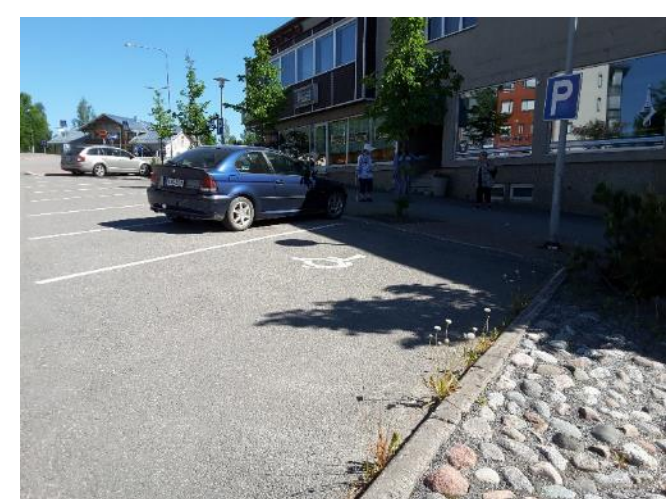
Koskentien varrella on LE-autopaikkoja, mutta maastonmuodoista johtuen sivukaltevuus niillä on liian suuri. LE-autopaikkojen reunassa on myös liian korkea reunatuki.
