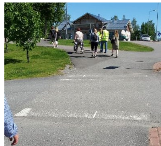
Reunatuet puuttuvat ja suojatiemaalaukset ovat kuluneet liikekiinteistön lähellä.
