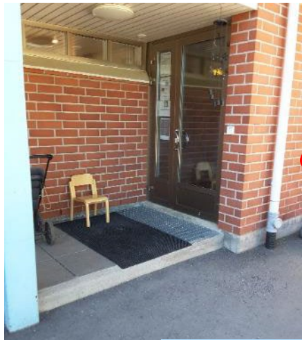
Luiska puuttuu (yllä) Kukeron puolella kaikkien ovien ja vaunujen säilytyspaikan edestä.
