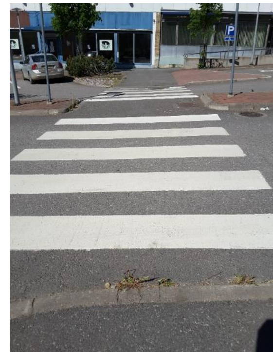
Reunatuet puuttuvat keskisaarekkeista Koskentiellä suojateillä.
