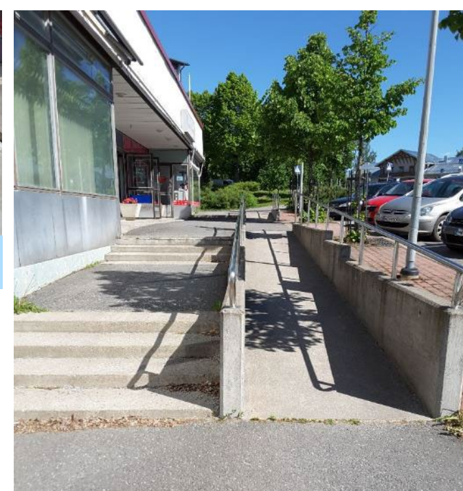
Liikkeiden edustalle on rakennettu luiskia kulkua helpottamaan.
