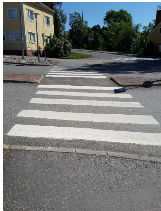
Reunatuet puuttuvat keskisaarekkeista Koskentiellä suojateillä.
