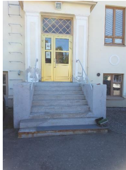
Terveyskeskuksen pääovi on esteettömyyden kannalta suhteellisen hyvä. Oven edestä voisi kuitenkin poistaa kynnyksen esim. luiskaamalla, jolloin pyörätuolilla kulku tilaa helpottuisi.
