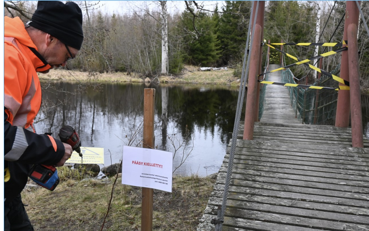
Joroisten kunnan teknisen toimen työntekijä sulki Loktien päästä lähtevän kevyen liikenteen riippusillan 8.5.2025. Päätöksen sulkemisesta teki sillan vuoden 2023 yleistarkastuksen pohjalta Joroisten kunnan rakennusvalvonta. Kuva: Kari Suhonen
