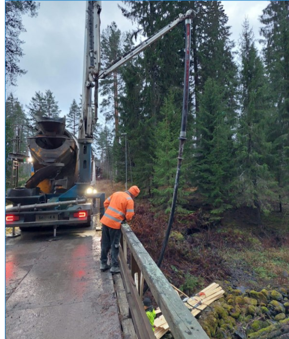
Ruukintien silta kunnostettiin vuoden 2025 lopulla. Betoni-vahvistusta valettiin tukirakenteisiin. Kuva: Risto Salko
