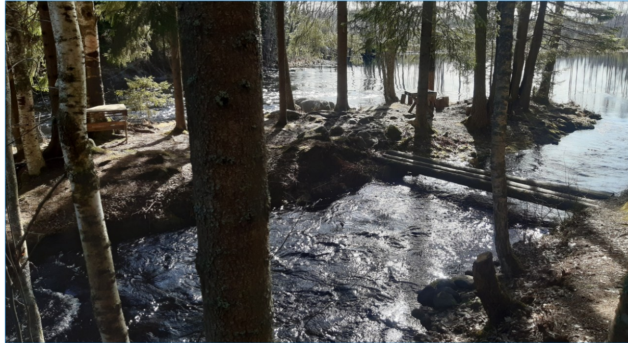
Pikkusaareen kuljettiin 2025 tukkisiltaa pitkin. Silta jäi tulvan aikaan vedenpinnan alapuolelle ja sen kunto oli heikkenemässä.
