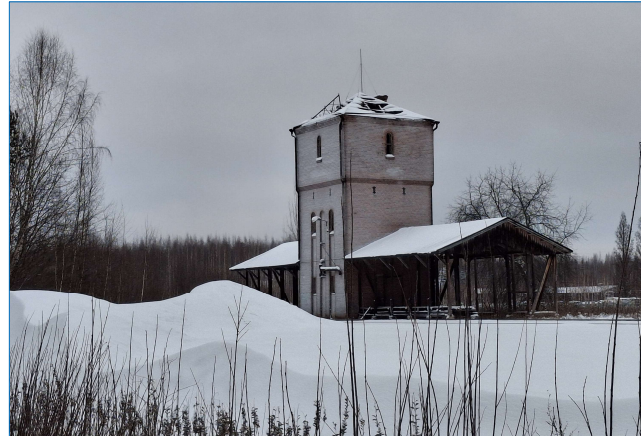
Väyläviraston omistaman vesitornin katon huono kunto huolestutti Huutokosken kehittäjiä. Asemapihan yli sadan metrin mittaisesta kivetyksestä suurin osa on jäänyt karikkeen alle.
