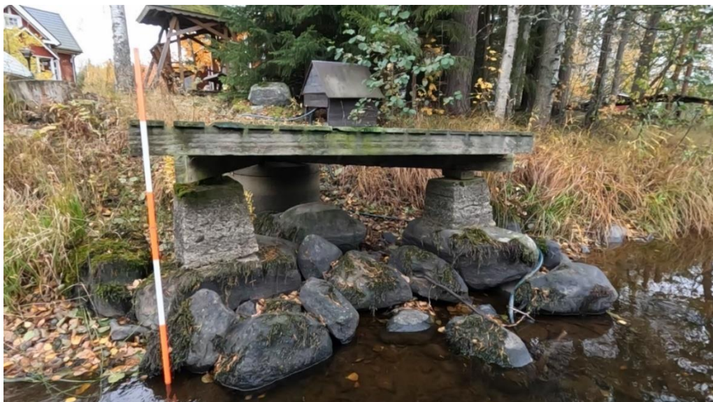
Kuva 32. Vahan rippusillan perustukset kosken etelärannalla. ©R.Kokko
