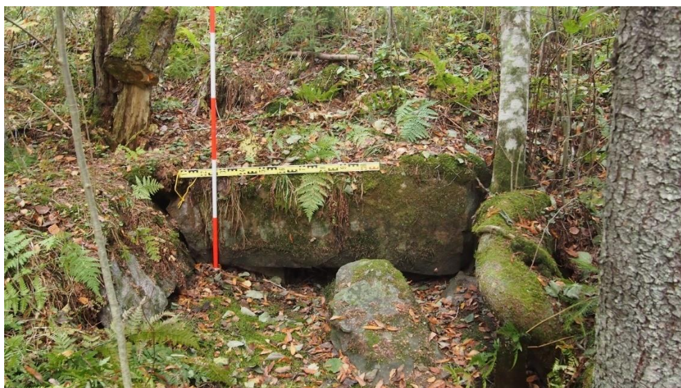
Siltarummun suuaukko tien eteläpuolella.
