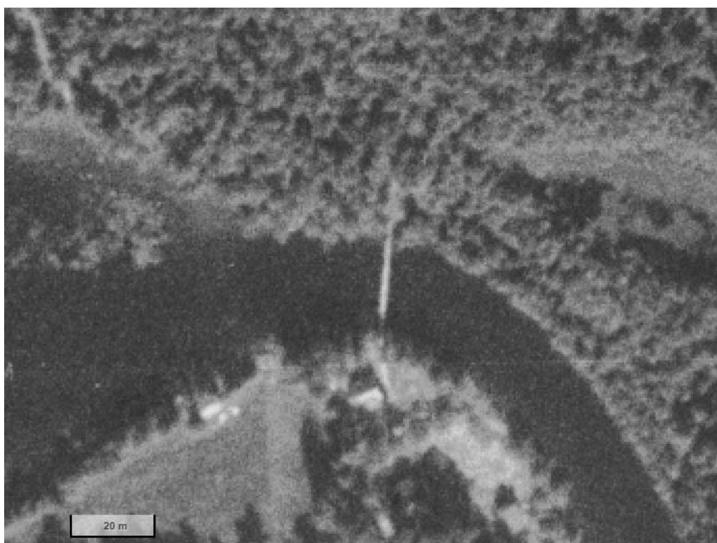
Kuva 33. Vanha riippusilta vuoden 1952 ilmakuvassa. ©MML, Paikkatietoikkuna
