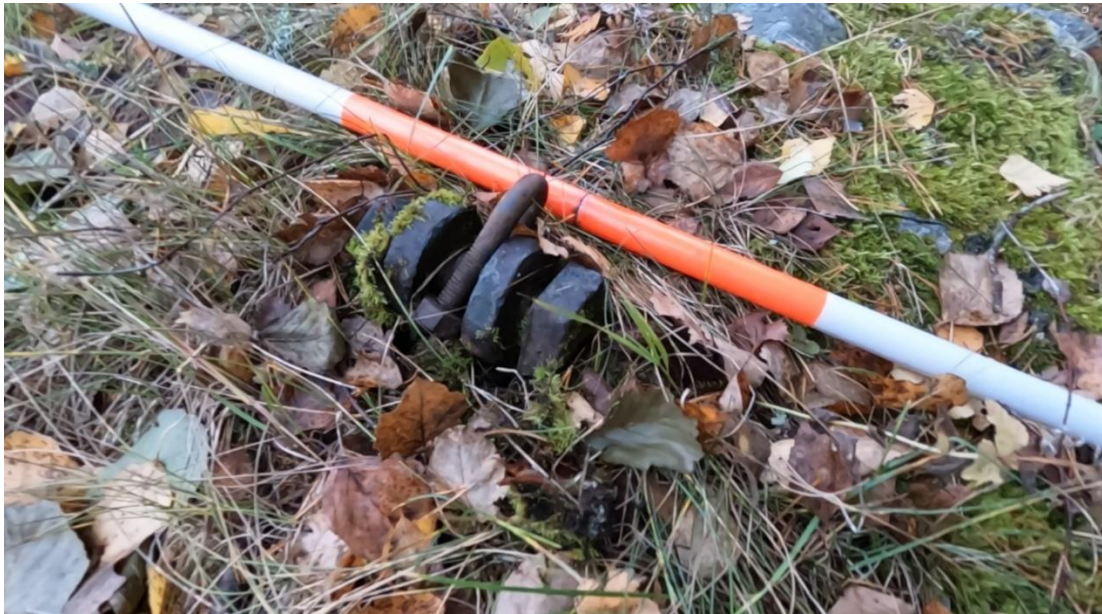
Vanhan riippusillan vaijerikiinnike etelärannan puolella (alakohde 1).
