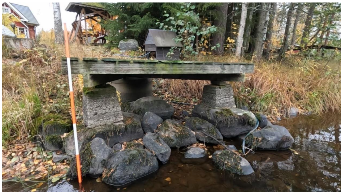
Vanhan riippusillan etelärannan perustukset. Kuvaussuunta etelään.
