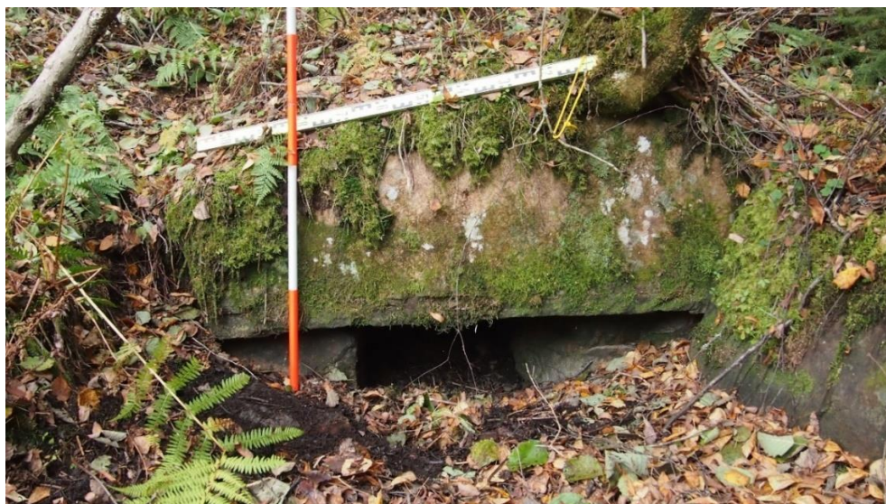
Siltarummun suuaukko tien pohjoispuolella.
